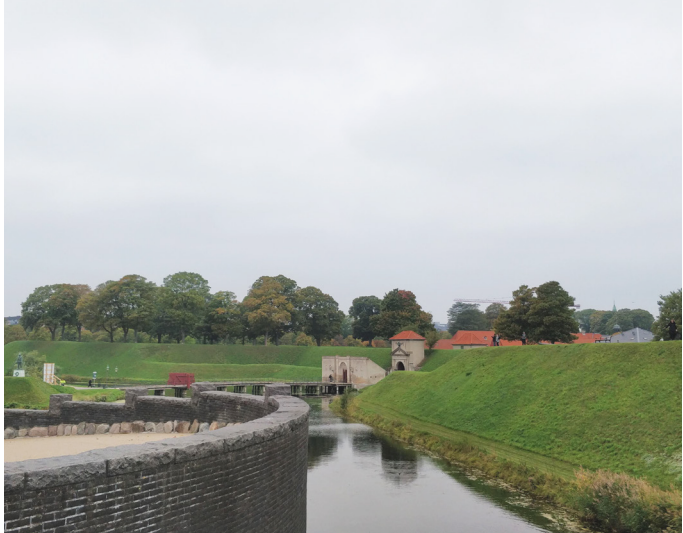
4 FÆSTINGSANLÆGGET KASTELLET SET FRA BROEN VED GEFIONSPRINGVANDET.
